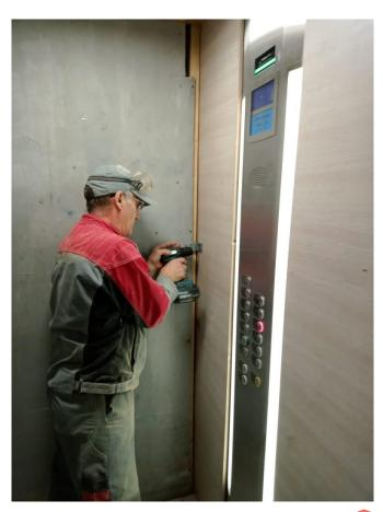
• Произведен монтаж защитной обшивки лифтовых кабин по адресам: ул. Архитектора Щусева, д. 5 к. 1 и д. 5 к. 2 — 12 лифтов
