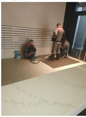
• Заменили вентиляторы напольных конвекторов на первых этажах дома по адресу: б-р Братьев Весниных, 2
